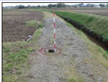
排水路からの吸出しにより発生した大きな陥没
