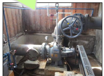
鉄管の腐食により漏水発生
