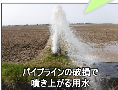
鉄管の腐食により漏水発生
